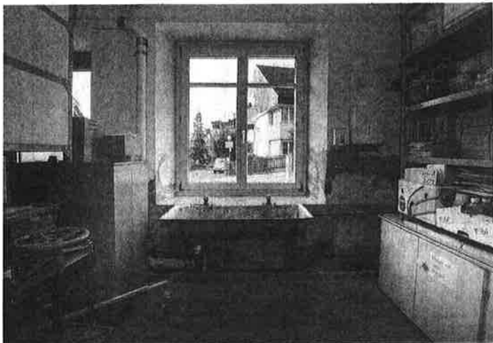
Feuchte Wände, veraltete Infrastruktur und zu wenig Platz im Werkraum.
